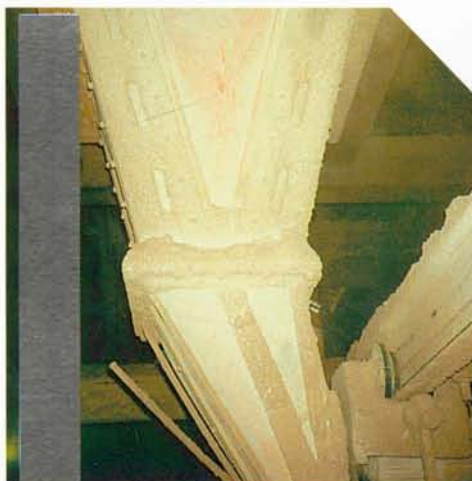
Nedstörtningstrumma i gödselmedelsfabrik belagd med Linatrile, vilket hindrar bryggbildning av material.
